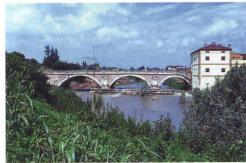
1569 Bridge over the Tesina River テシナ川の橋 S.S. N. 11 Padana Superiore, Torri di Quartesolo, Italy
