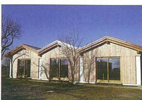
X-Lamパネルを使ったCLT工法の木造住宅
