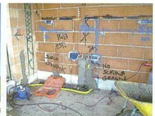
間仕切り壁下部はオートクレーブ養生した気泡コンクリートブロック。配管位置はスプレーで。レンガ造壁が、実寸の展開図になる。
