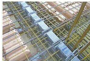
躯体から飛び出るバルコニー付け根は熱橋ポイント。断熱材と鉄筋がプレハブ加工された梁と一体でコンクリート打設。
