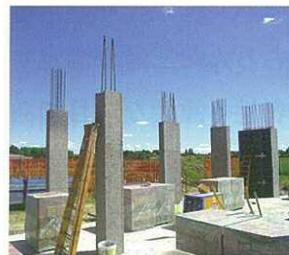
柱は木毛セメント板と共に打設
