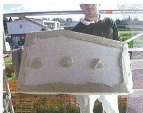
断熱材用接着剤の正しい配置。だめ出しの際にこのような写真も報告として送られた。
