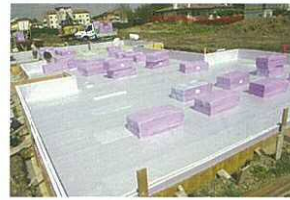
別のプロジェクト。40cmの基礎底盤の下部に押出ポリスチレンフォーム。建物全体の重量を受ける。
