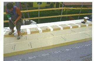
屋根断熱材ウッドファイバー240mm厚
