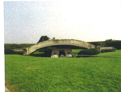
大地を跨ぐアーチ
