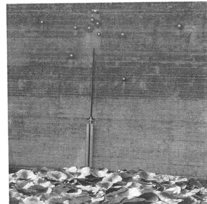
入口棟壁面の分銅
