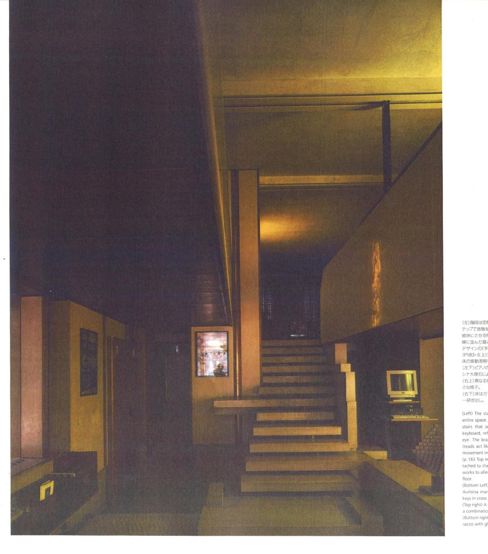
(左)階段は空間全体の核となっている。ステップで音階を弾くような、精緻、かつ人を愉快にさせる階段の傑作中の傑作。一直線に並んだ踏み板の真鍮の支持金具が、デザインの「手綱」となっている。(P183・左上)室内パルコニーの吊り柱。床の振動周期を緩和する。(左下)ピアノの鍵盤を彷彿させる、アウリシナ大理石による段板の小口。(右上)異なる素材の組み合わせによる小さな格子。(右下)床はガラスタイルを埋めたテラゾ
